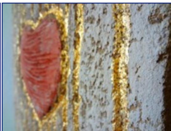
**Oben:** Lehmwandheizung mit 24 Volt Niedervolt, Strahlungswärme-Infrarot
